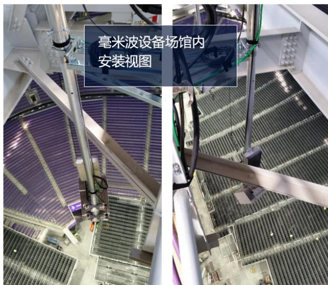
图 13 U.S. Bank 体育馆 5G 毫米波部署情况
